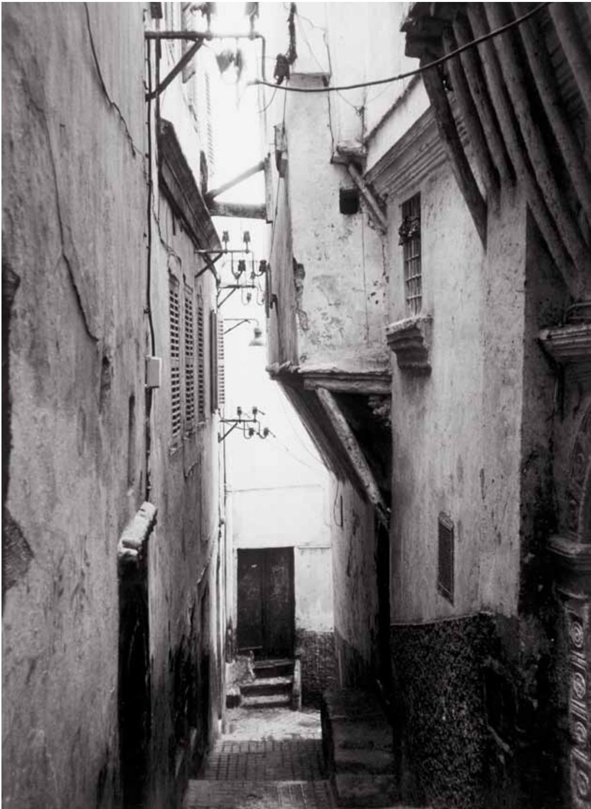
Ruelle dans la Casbah d'Alger.
